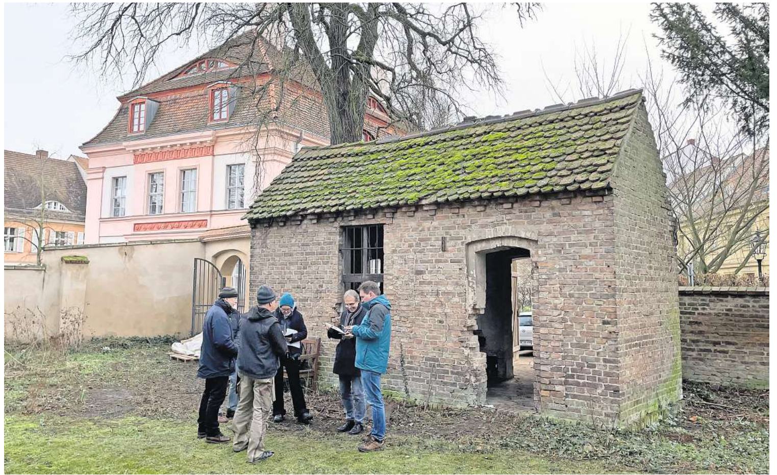
Baubesprechung am ehemaligen Dom-Gefängnis: Die Sträucher, die das Gebäude zugewuchert hatten, sind schon mal weg.
